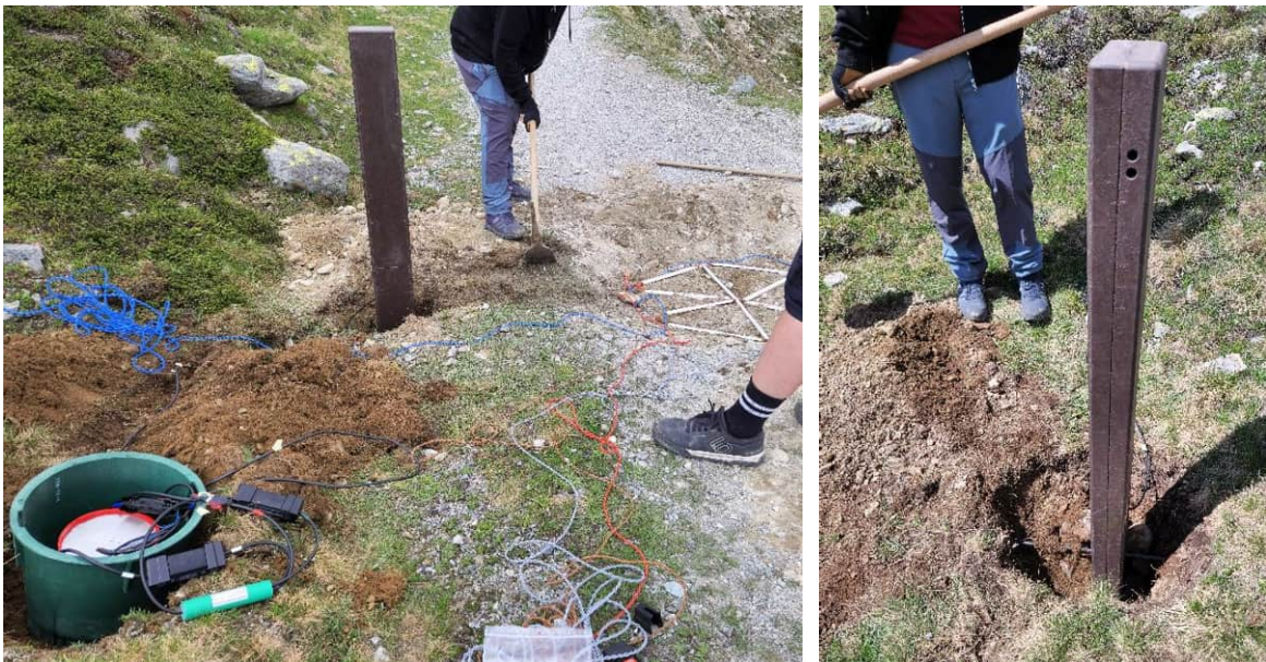
Abbildung 3: Einbau des MULTI-Sensor (Pfosten) und des Plastikbehälters mit Batterie und Logger
