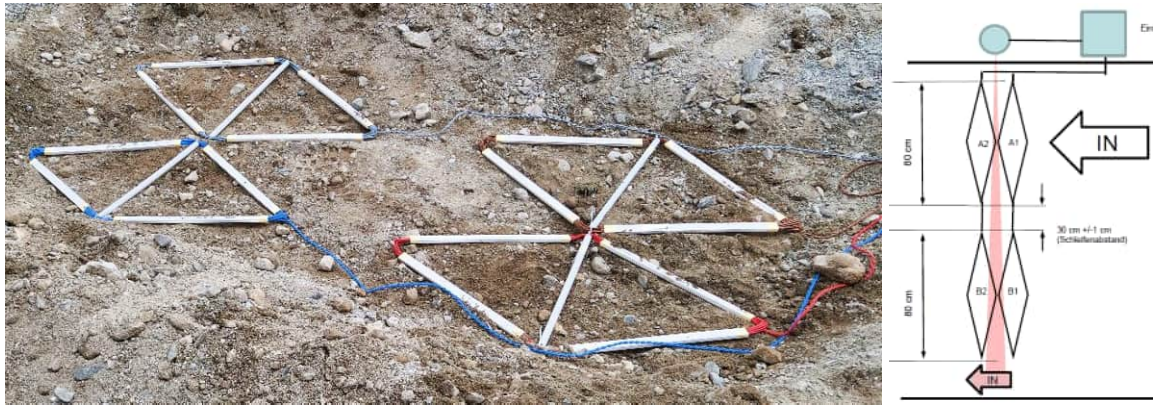
Abbildung 4: Verlegen der Induktionsschleifen (links) sowie Schema von deren Anordnung (Quelle: Eco-Counter)
