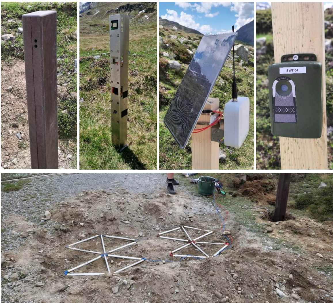
Abbildung 1: Die installierten Geräte, obere Reihe von links nach rechts: Pfosten mit Infrarotsensor von Eco-Counter, Radarsensoren PollR und XCR von Parametric; Infrarotsensor von Swisstraffic, untere Reihe: Induktionsschleifen fürs Velo von Eco-Counter.
