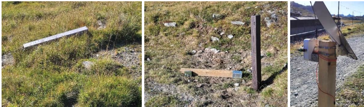
Abbildung 10: Schadensbild nach dem ersten Vandalismus von Ende Juli, Anfang August 2023.
