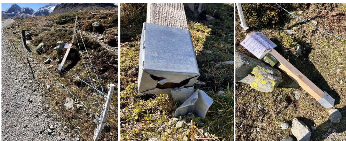
Abbildung 14. Schadensbild nach dem fünften Vandalismus, fotografiert am 24. September 2023.
